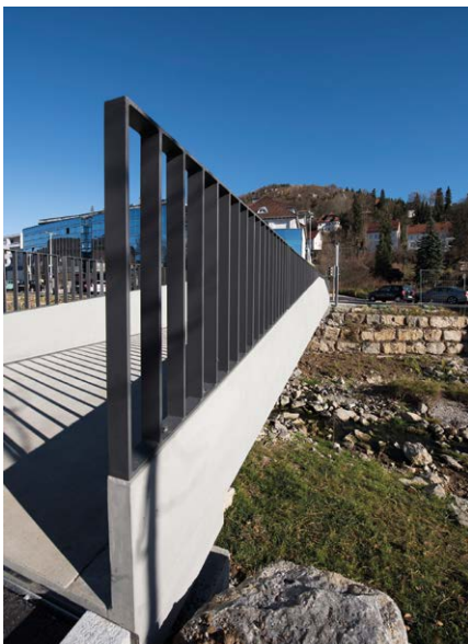
Komplett aus Textilbeton: Die Radwegbrücke in Albstadt-Ebingen
