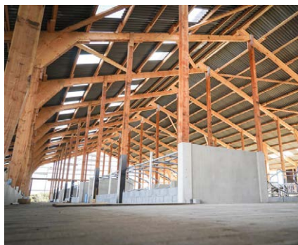
Werden Hallen mit Holz gebaut, wird meist Brettschichtholz (BSH) eingesetzt, um ein Verdrehen des Holzes und Rissbildung durch Änderung des Feuchtegehalts zu reduzieren.
