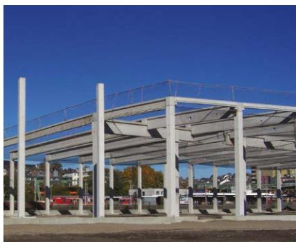
Halle aus Stahlbetonfertigteilen: Die erwartete Nutzungsdauer von 33 Jahren ist bei einer massiv gebauten Halle laut AfA-Tabellen ungefähr doppelt so hoch wie die von Holzkonstruktionen.
