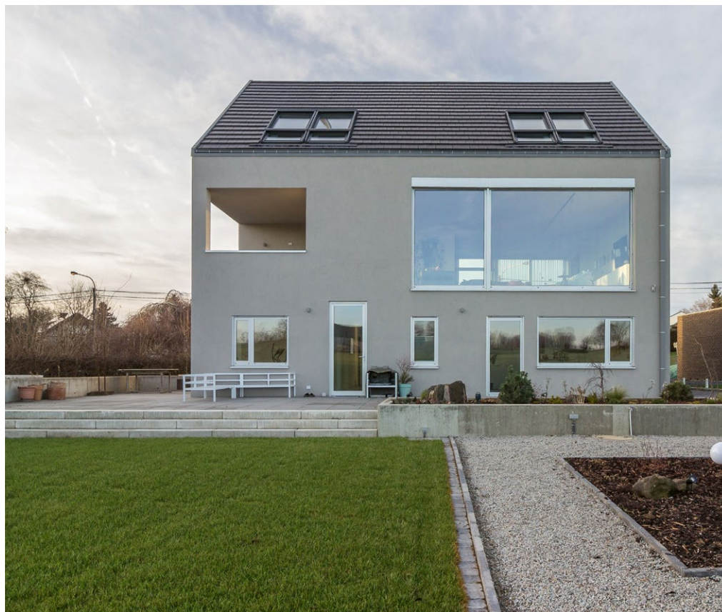
Foto: Wimmer / bernward sutmann architekt / Michael Maassen
