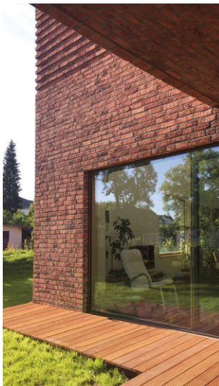
Foto: Niewoik / bepotbau
