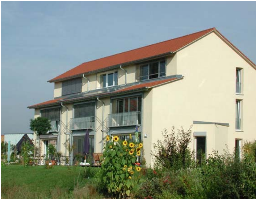
Reihenhaus in Passivhausbauweise, Architekt H. Brenner
