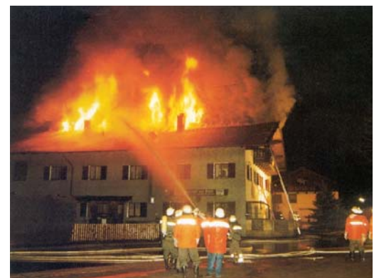
Dachbrände weiten sich schnell aus
